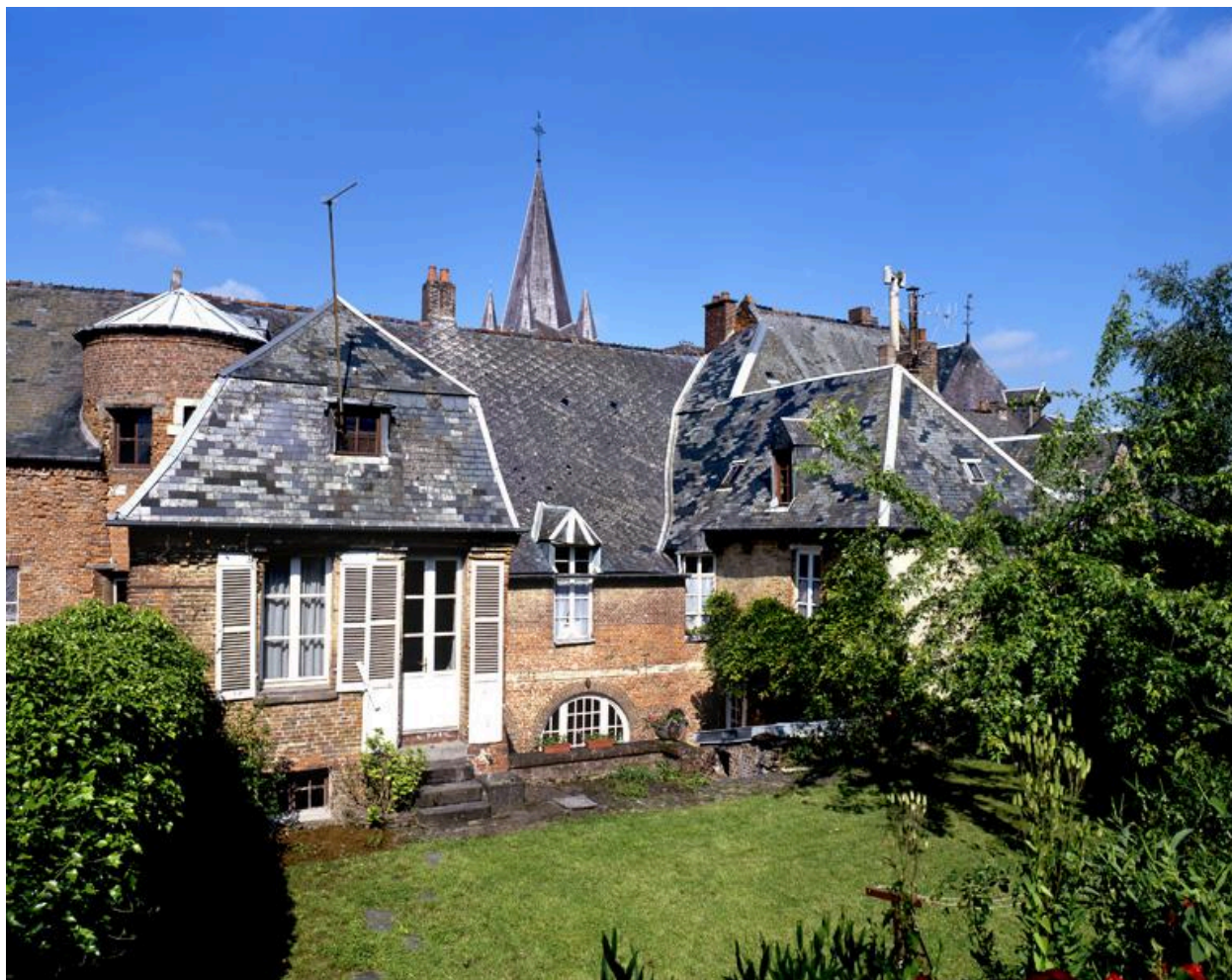
Vue des élévations depuis le jardin.
