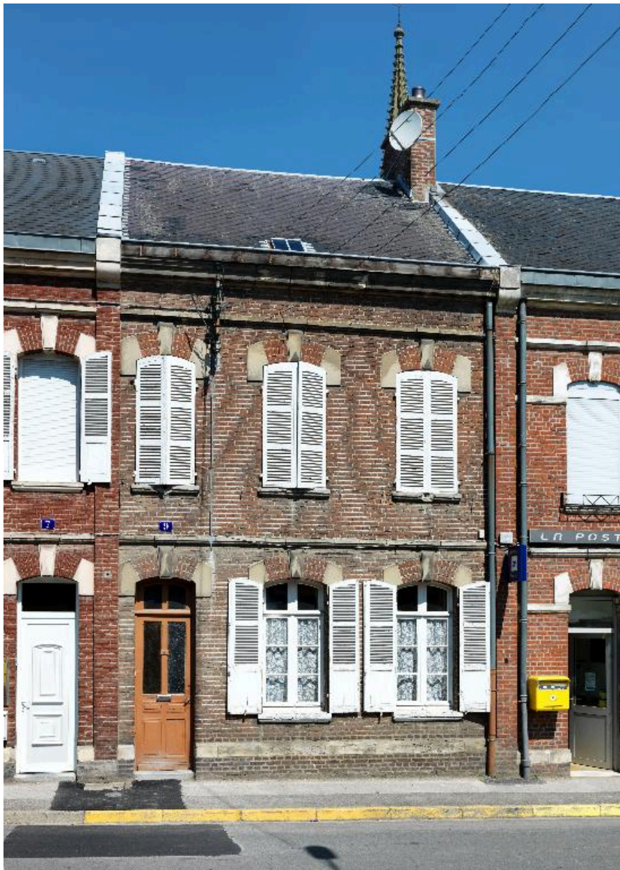
Elévation sur rue de la maison située au 9 rue Charles Cagny.
