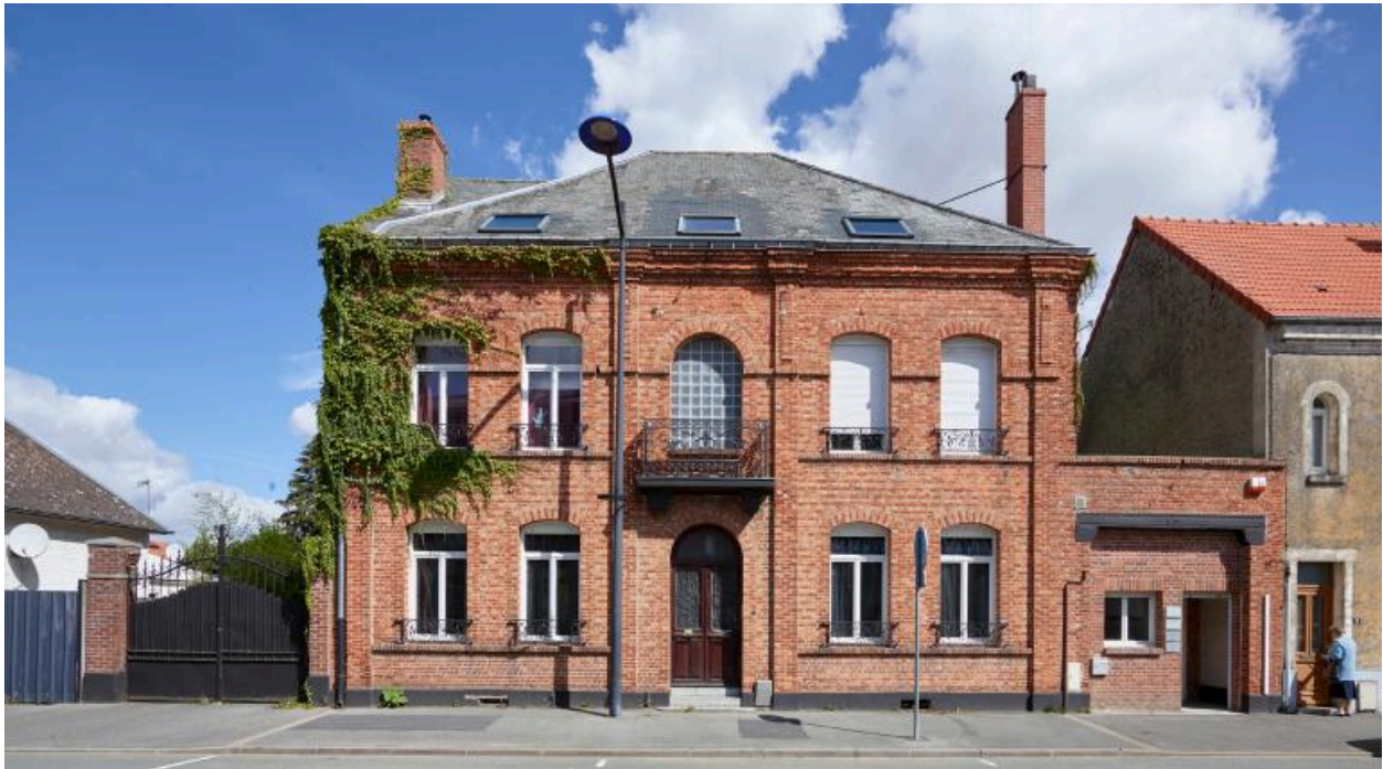
Maison, n° 4 rue du faubourg de Péronne. Vue de la façade principale. Exemple de maison bourgeoise avec distribution centrale.
