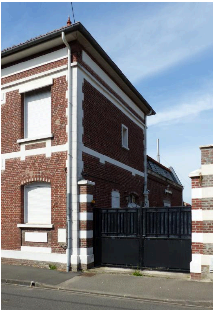
Vue partielle des anciens ateliers.
