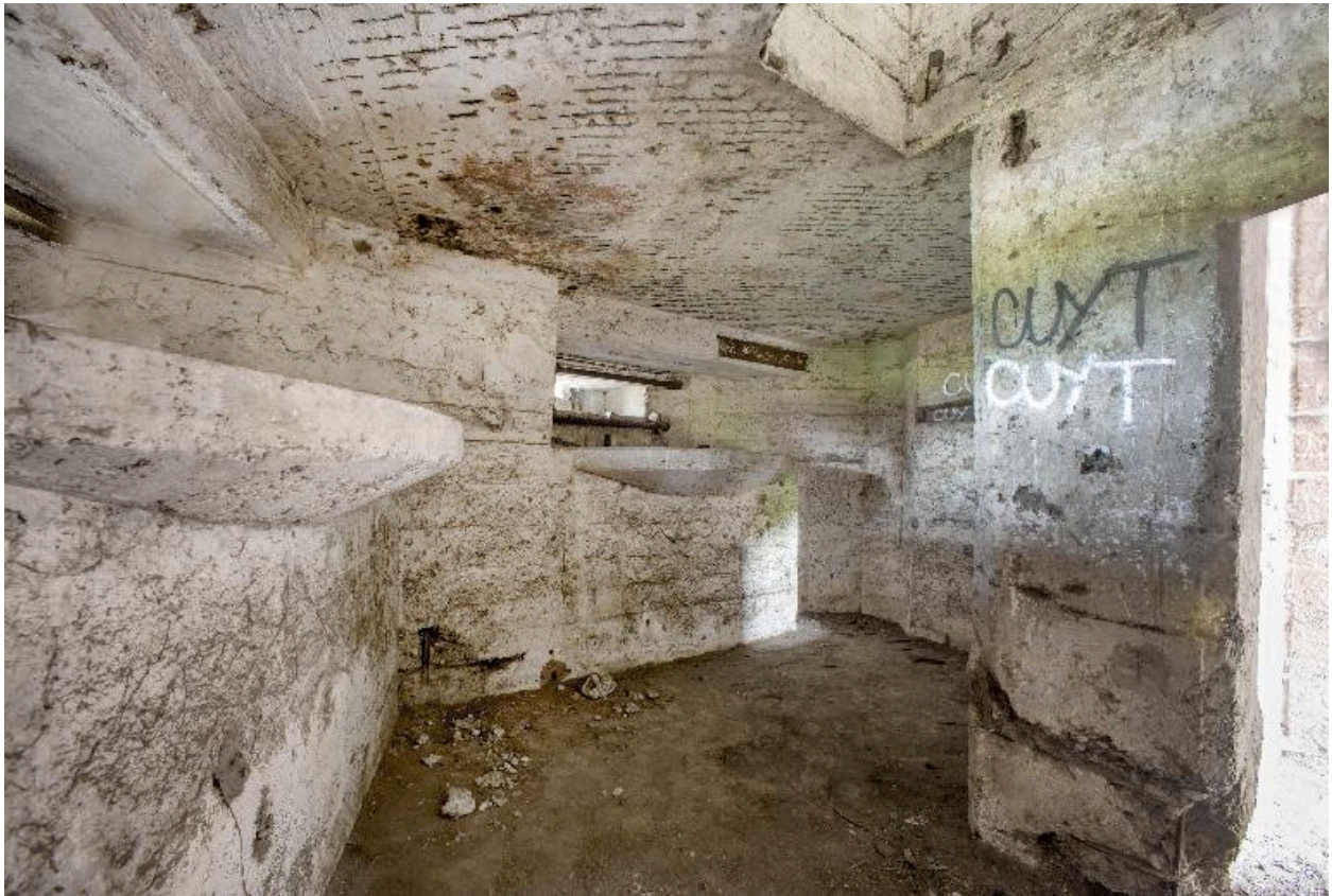
Vue générale du rez-de-chaussée (au grand-angulaire)
