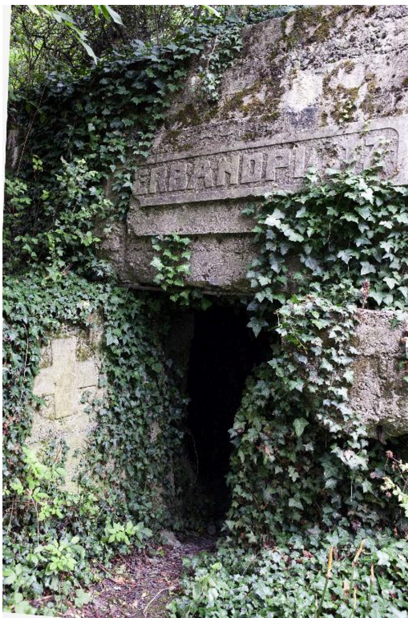
Entrée sud surmontée encadrée de ses deux cartouches
