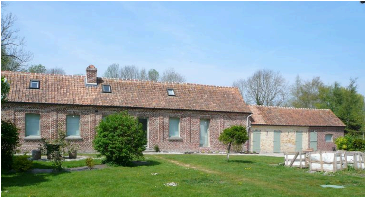
Vue des étables au sud-ouest.
