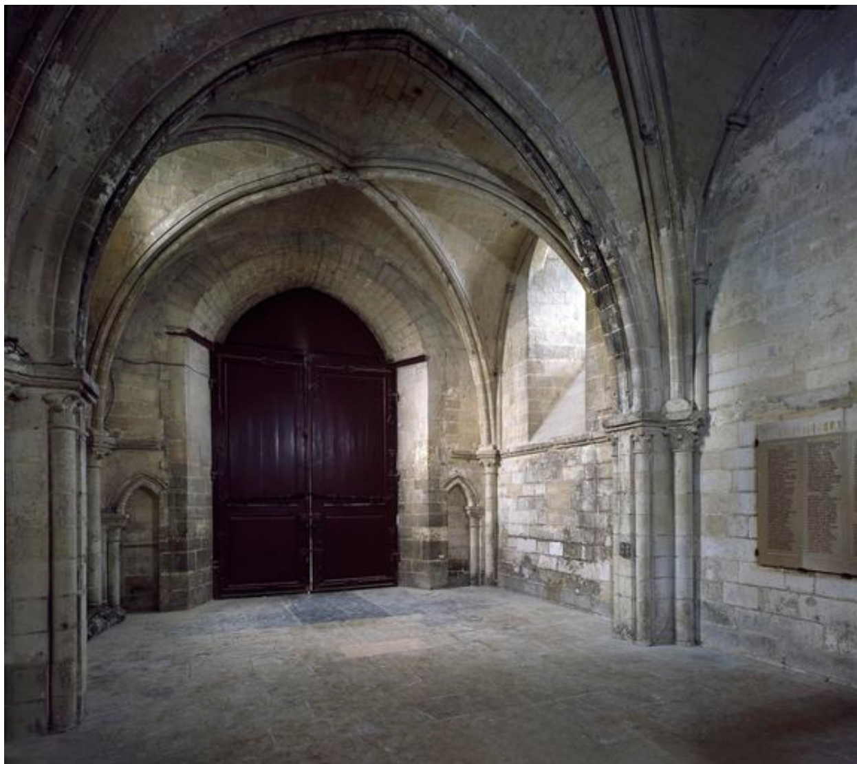
Vue du rez-de-chaussée du clocher-porche.
