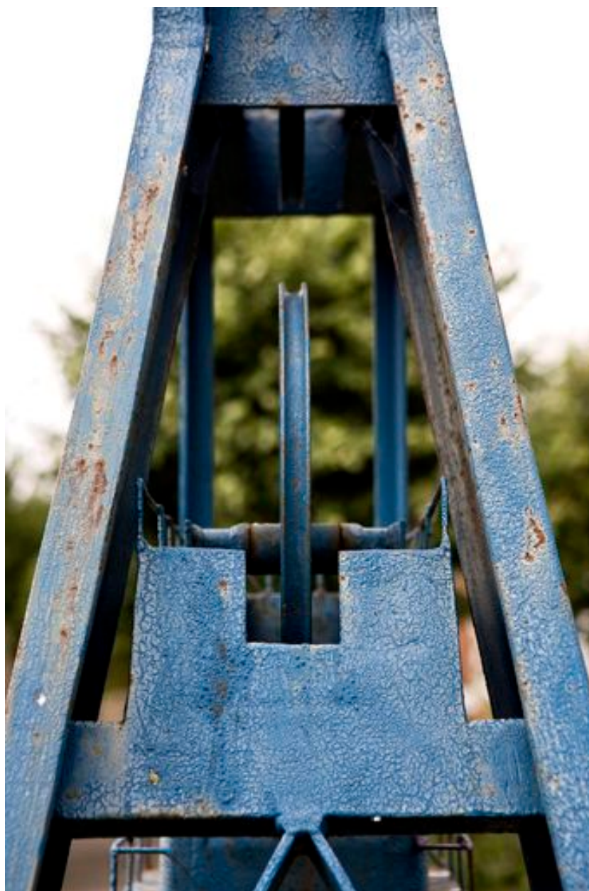
Chevalement du 7 d'Avion, détail.
