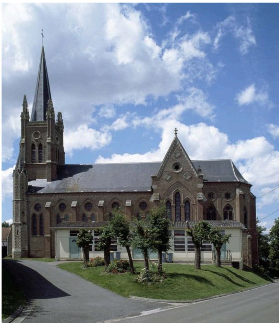
Vue générale depuis l'est.
