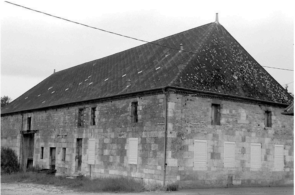
Vue depuis le nord-est.
