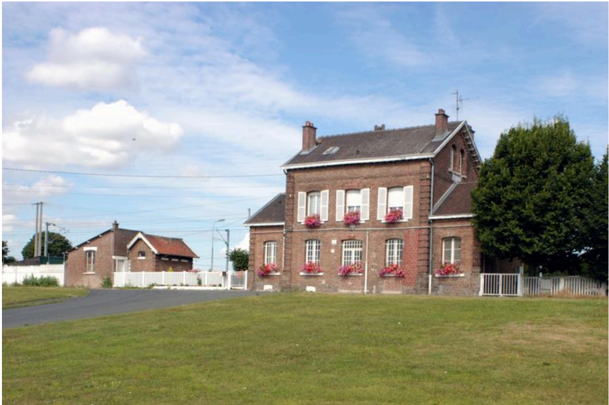
Vue de la façade est.
