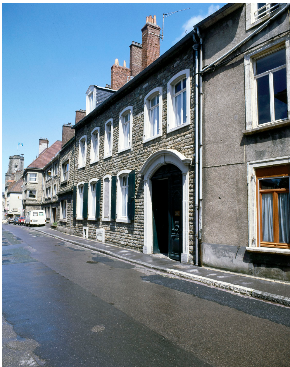
Façade sur voie.
