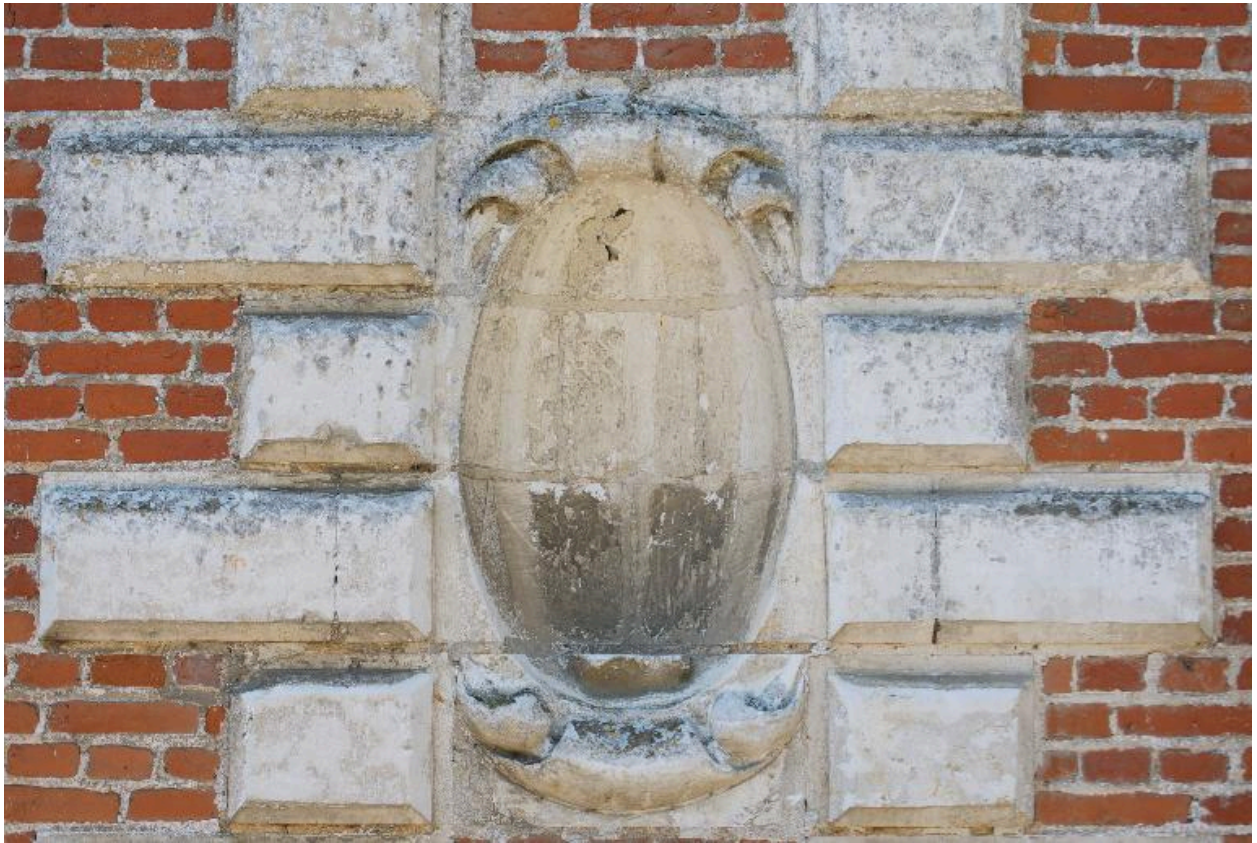
Niche concave ovale de la façade du corps de logis principal.
