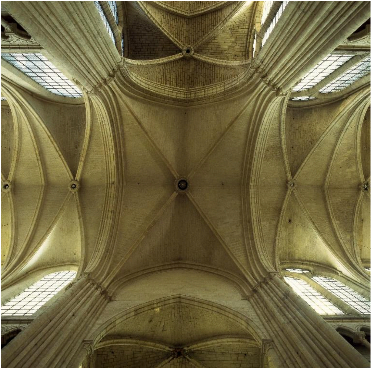
Vue de la voûte de la croisée du transept.
