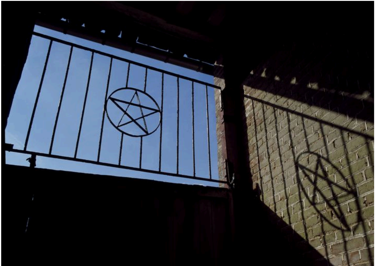
Imposte de la porte charretière.
