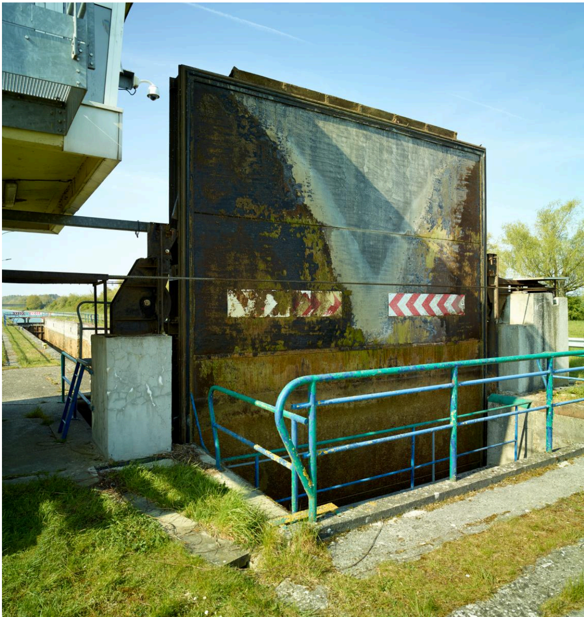
Porte levante en aval du site.
