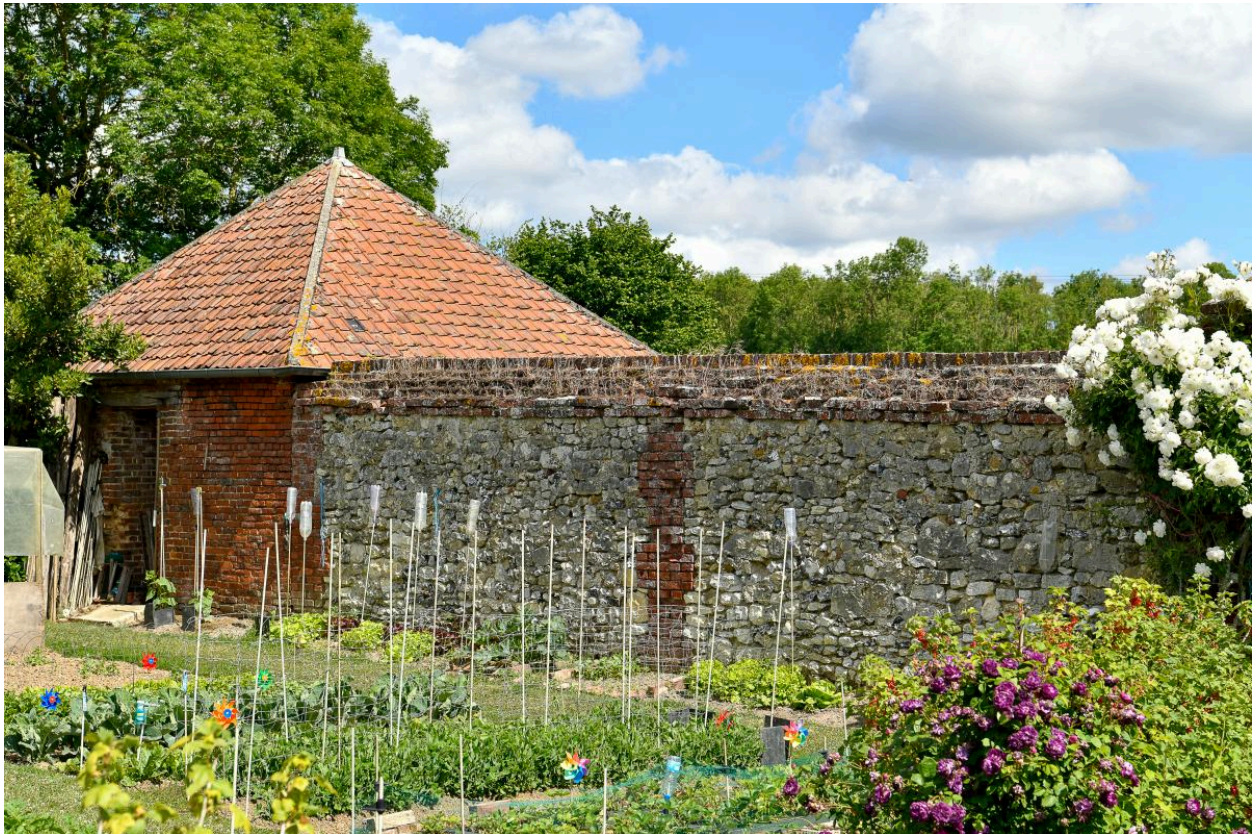
Mur de clôture et fruitier, vue depuis le sud-est.
