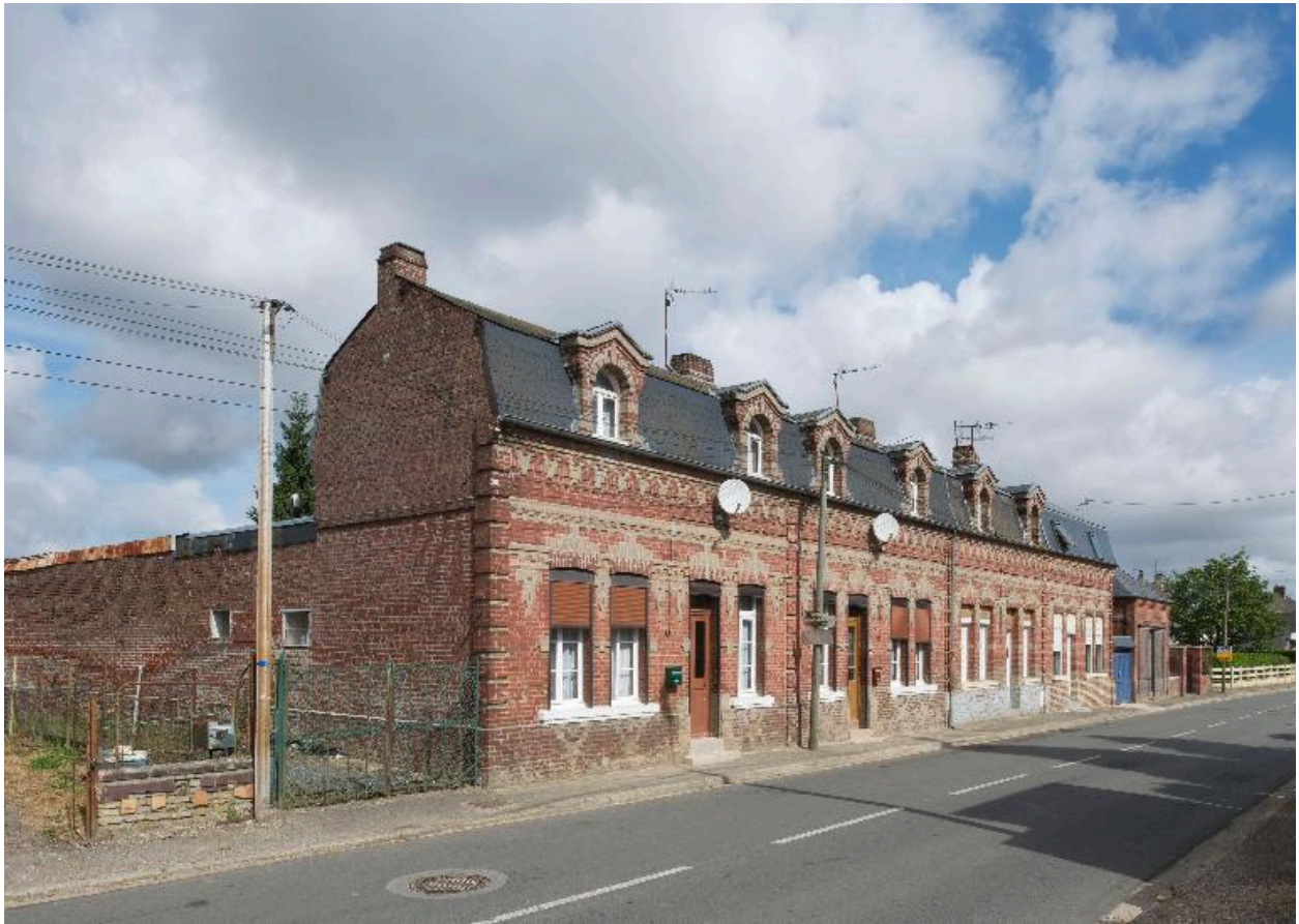
Maisons de rapport, construites en 1910, rue de Cornehotte.
