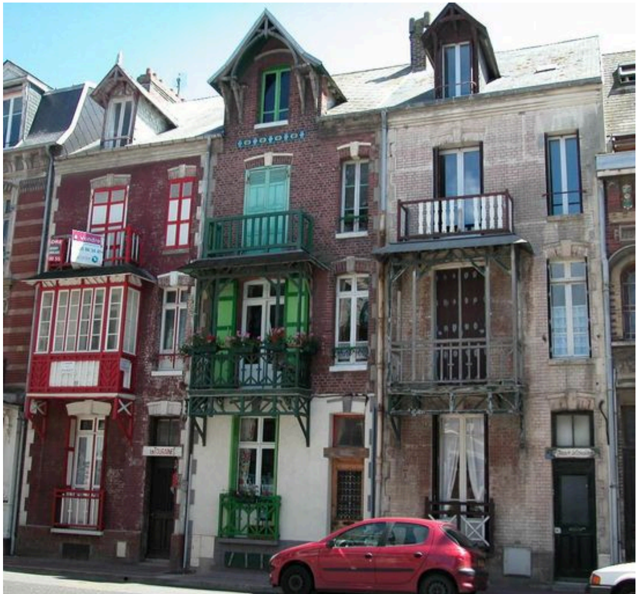
Élévation à 3x2 travées (10, 12, 14 avenue du Maréchal-Foch).
