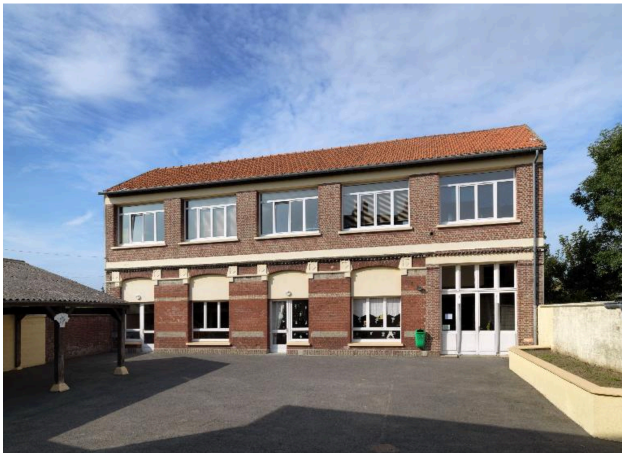
Vue du bâtiment abritant les salles de classe.
