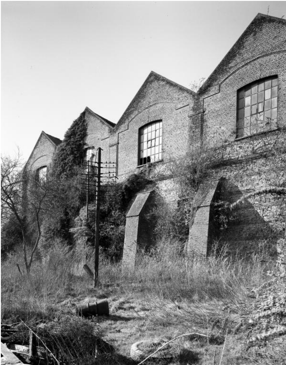
Remise ferroviaire et contreforts. Élévation postérieure, sur la Sambre.
