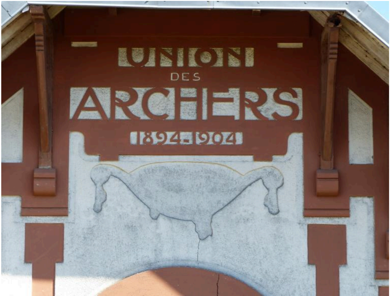
Vue du fronton de la façade sud.
