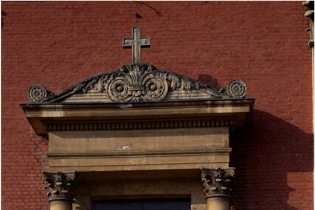
Détail sur le fronton du porche occidental.
