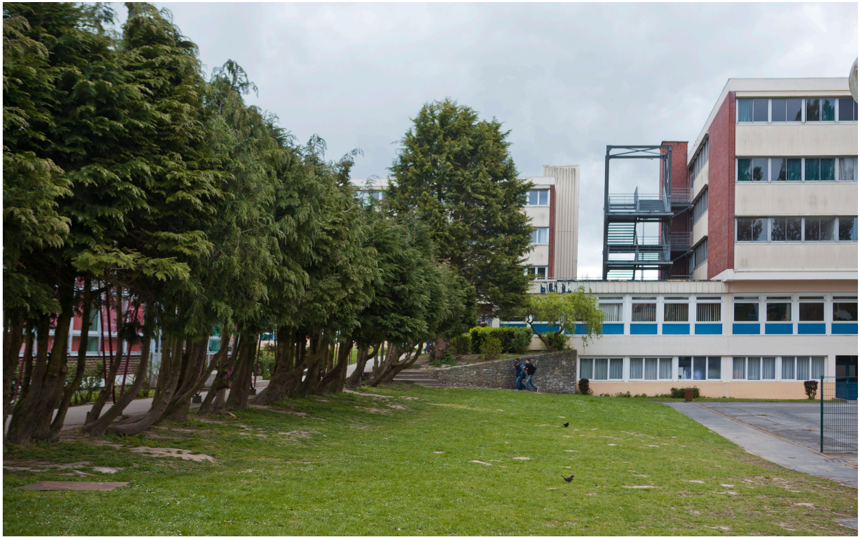
Internat de filles (lycée) : façades ouest - détail, 2016.
