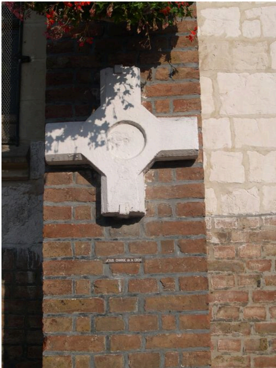
Vue de détail du chemin de croix extérieur (mur sud, à l'est de la porte).
