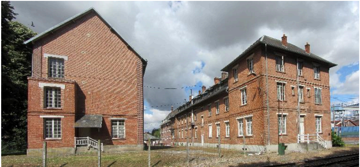
Façade postérieure de la cantine et pignon du bâtiment des cuisines.
