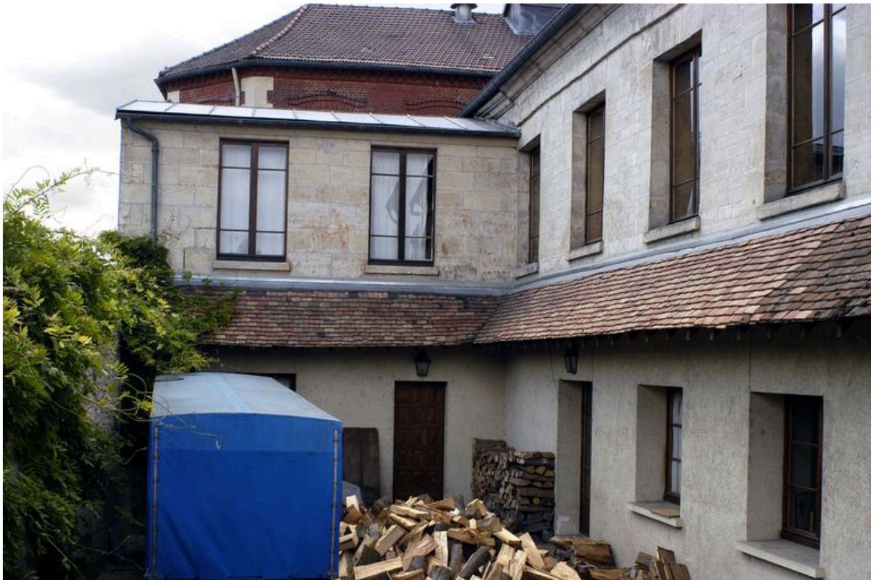
Vue d'ensemble de la filature, façade antérieure, avec son extension en retour.
