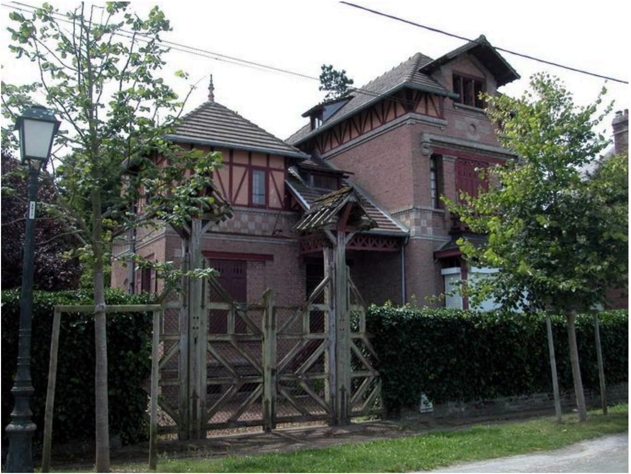
Vue d'ensemble depuis la digue.
