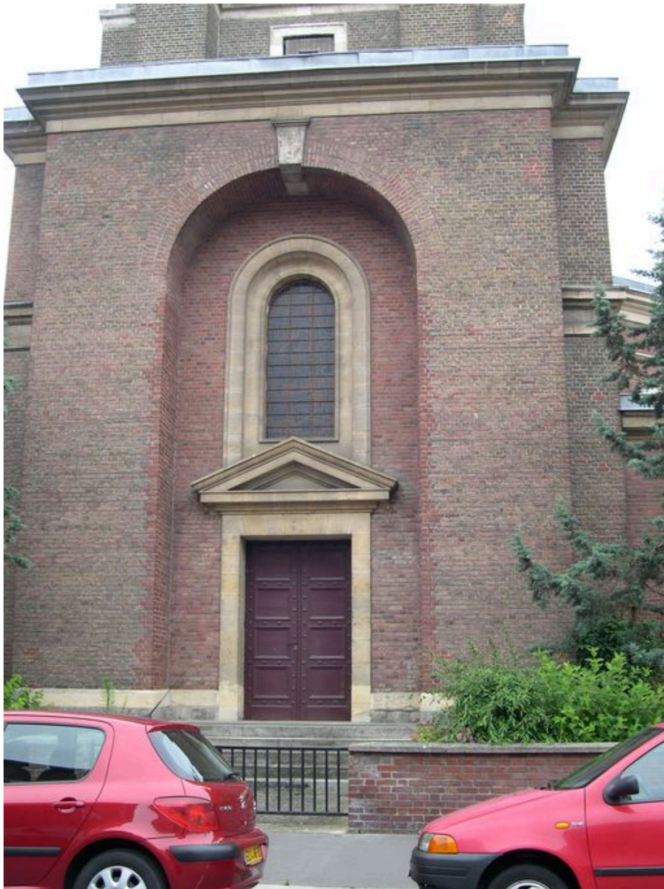
Vue de détail : baie est de la tour de clocher.
