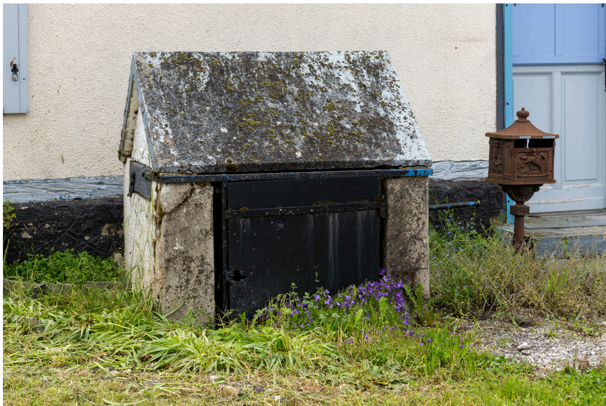
Puits, placette au croisement des rues de la Montagne et du Bout de la Ville.
