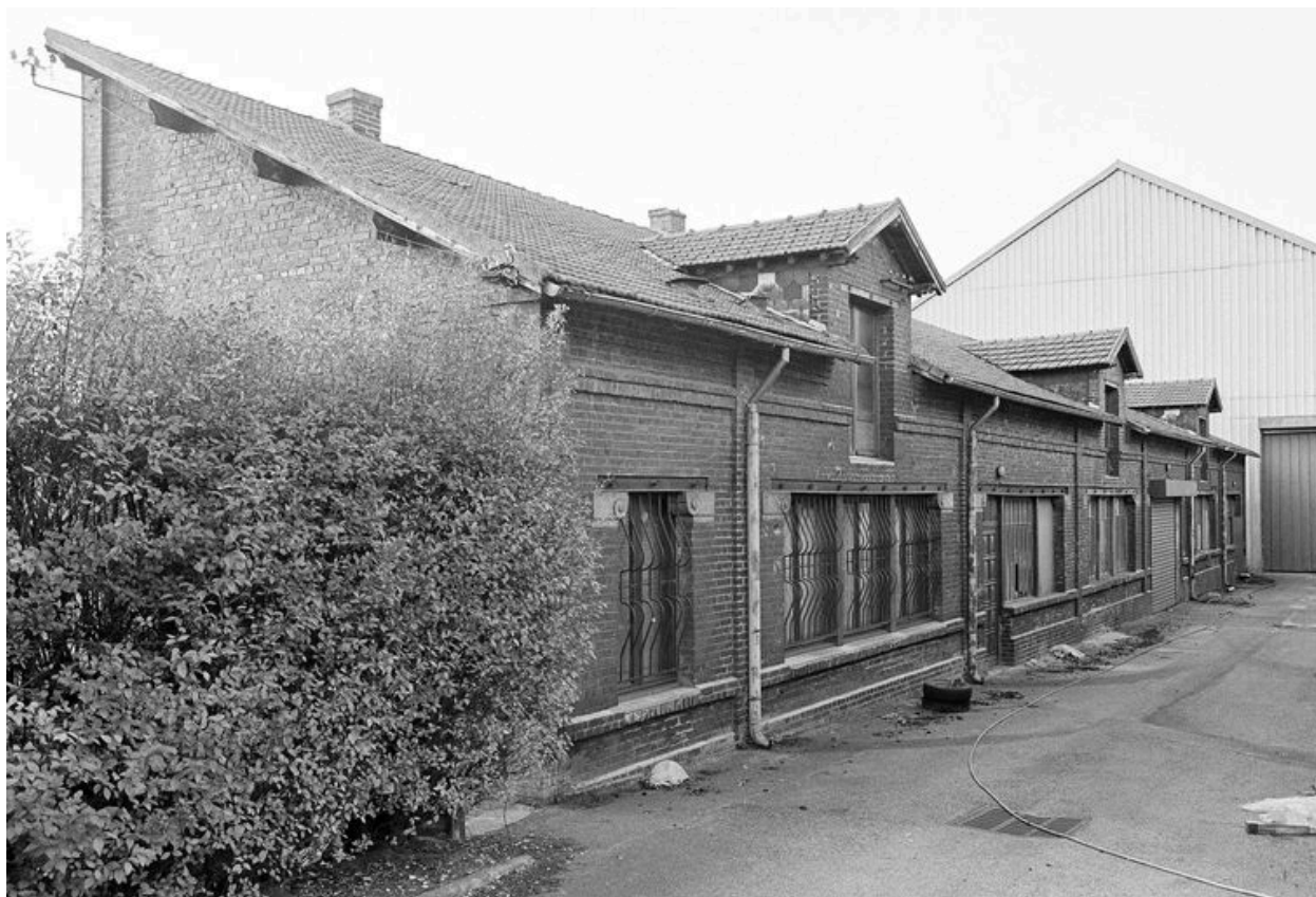
Remise, ateliers de fabrication secondaires.
