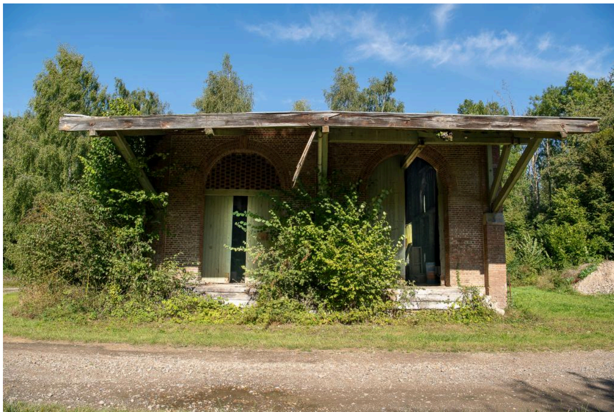
Vue générale depuis le sud de l'ancien entrepôt ferroviaire.
