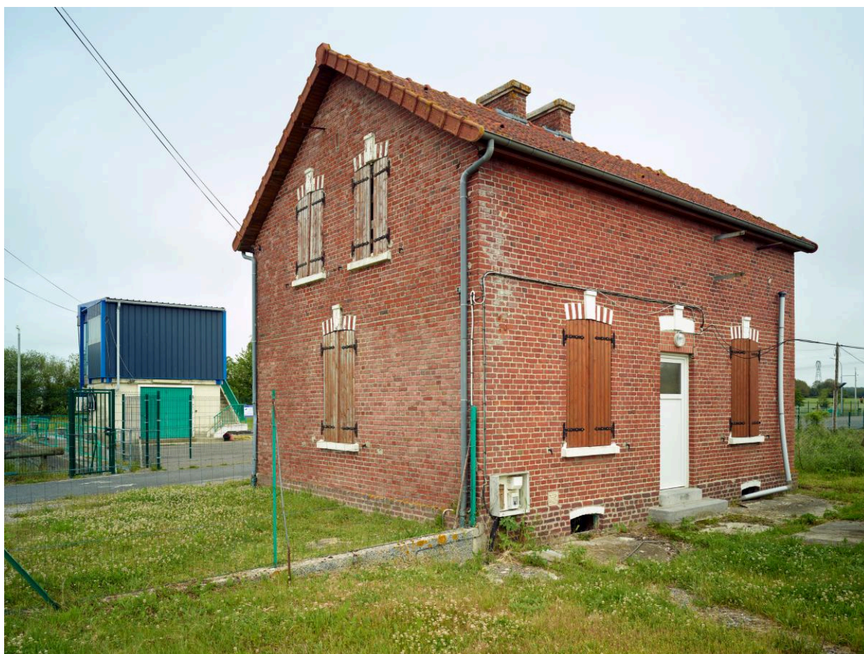
La maison de service (aval).
