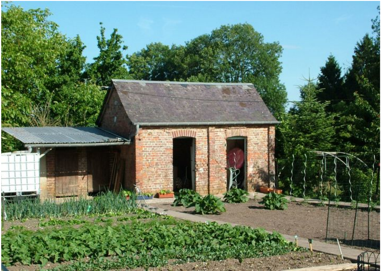
Ancien bâtiment du bûcher et des toilettes au fond du jardin.
