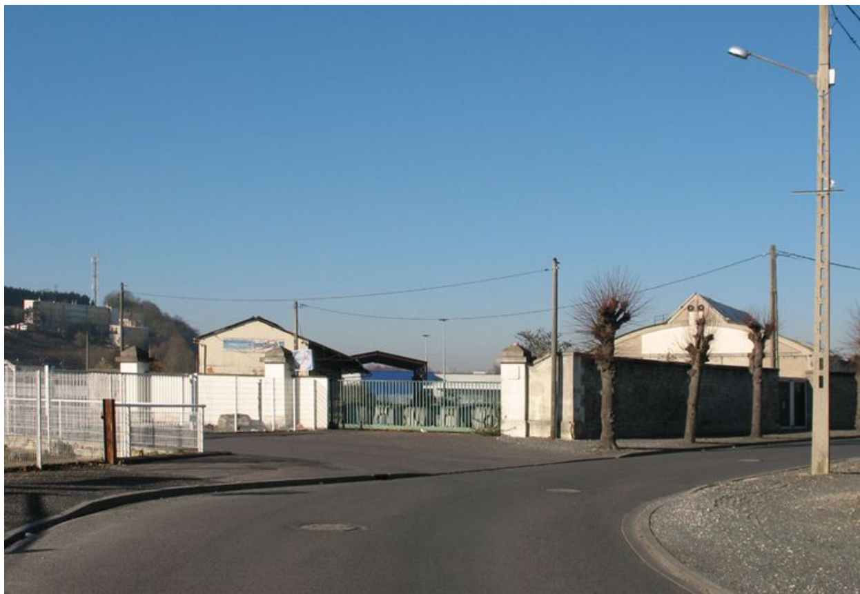
Entrée des anciens établissements Borg et Lévy.
