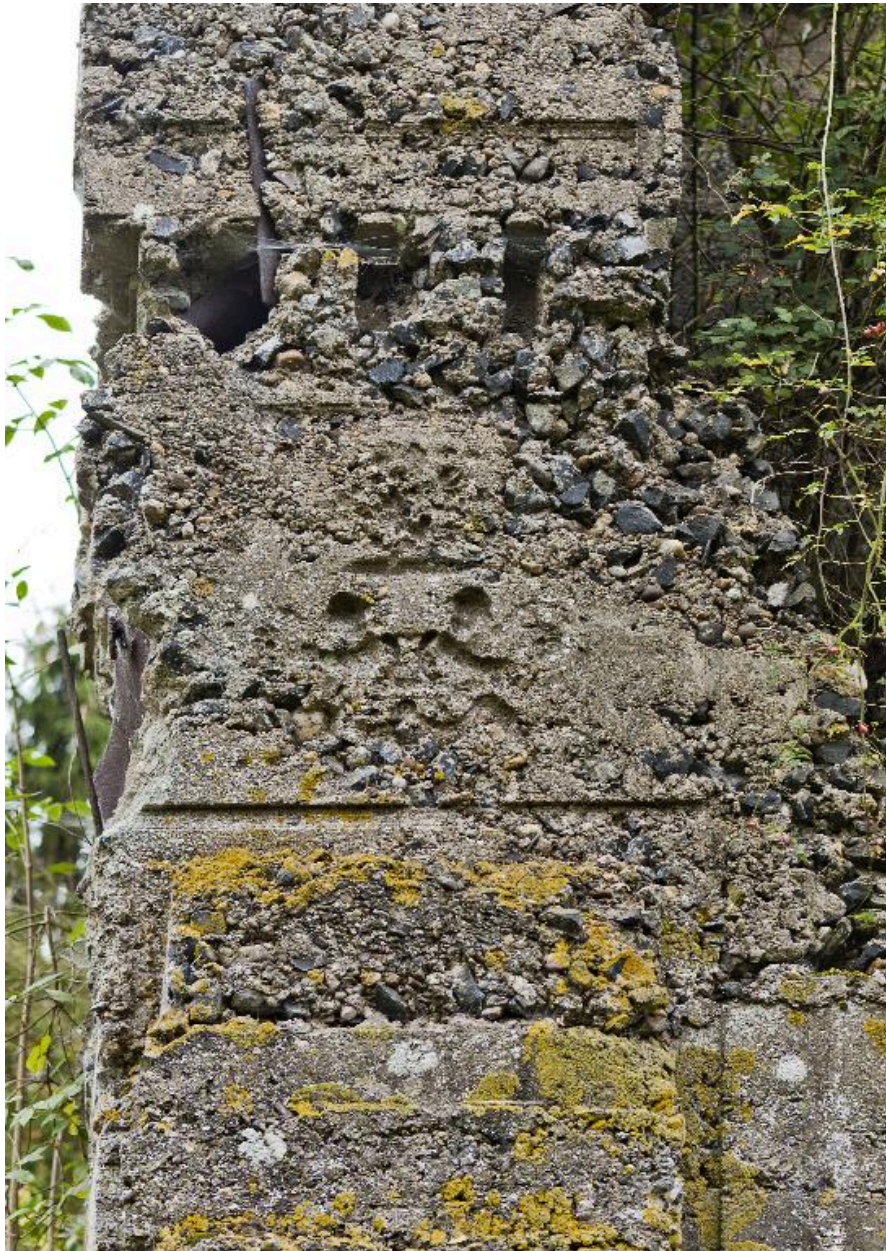
Détail du contrefort est : Angelots d'un bois de coffrage
