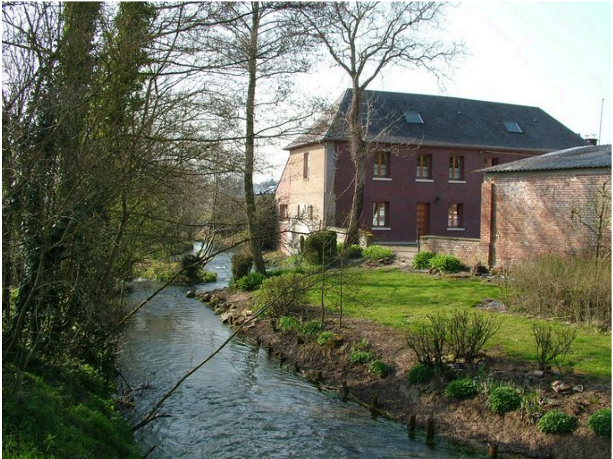
Vue générale des bâtiments de l'ancien moulin depuis la Nièvre.
