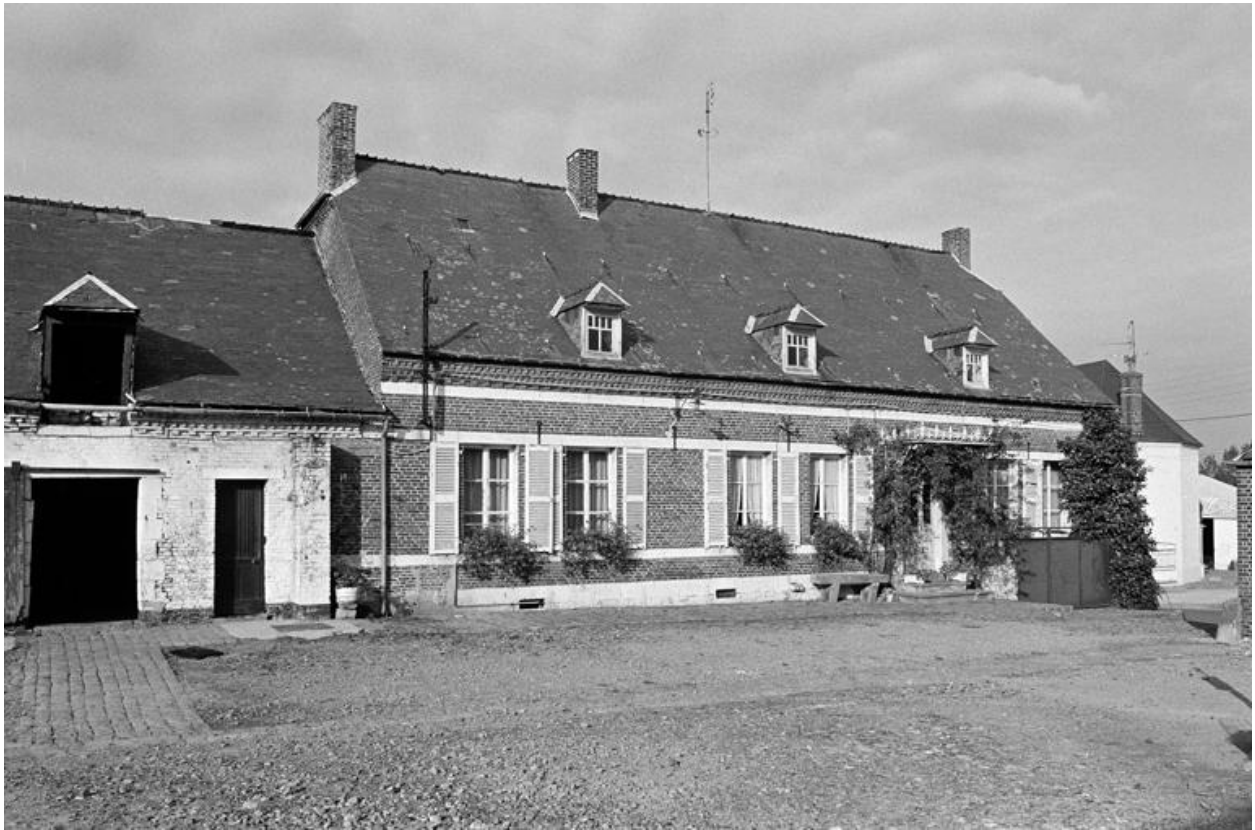
Vue d'ensemble du logis, depuis le sud-ouest.
