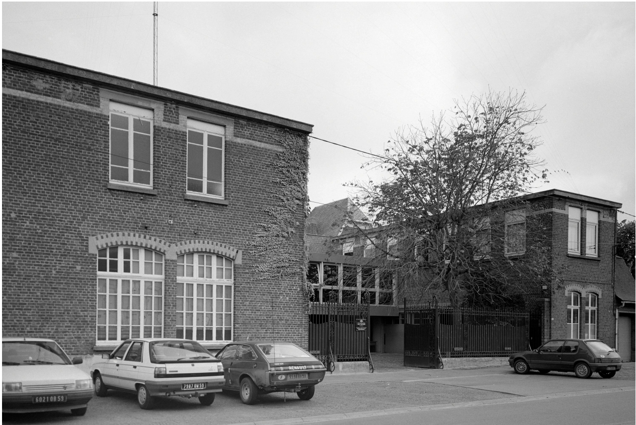
Ateliers de fabrication, élévation antérieure.
