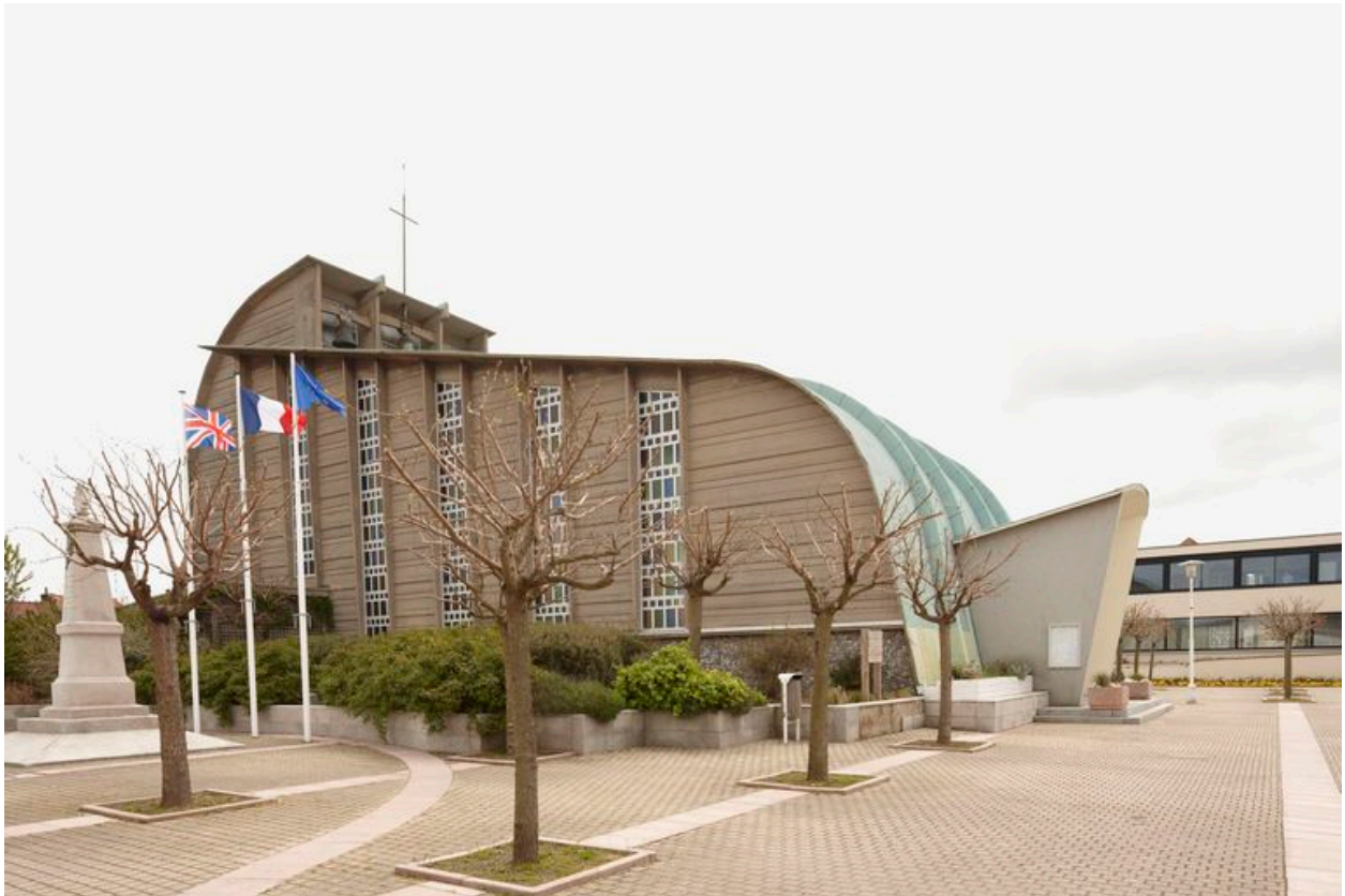
Vue générale de l'élévation latérale.
