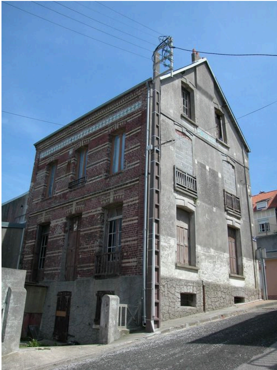
Vue de trois-quarts sur les élévations postérieure et latérale gauche.
