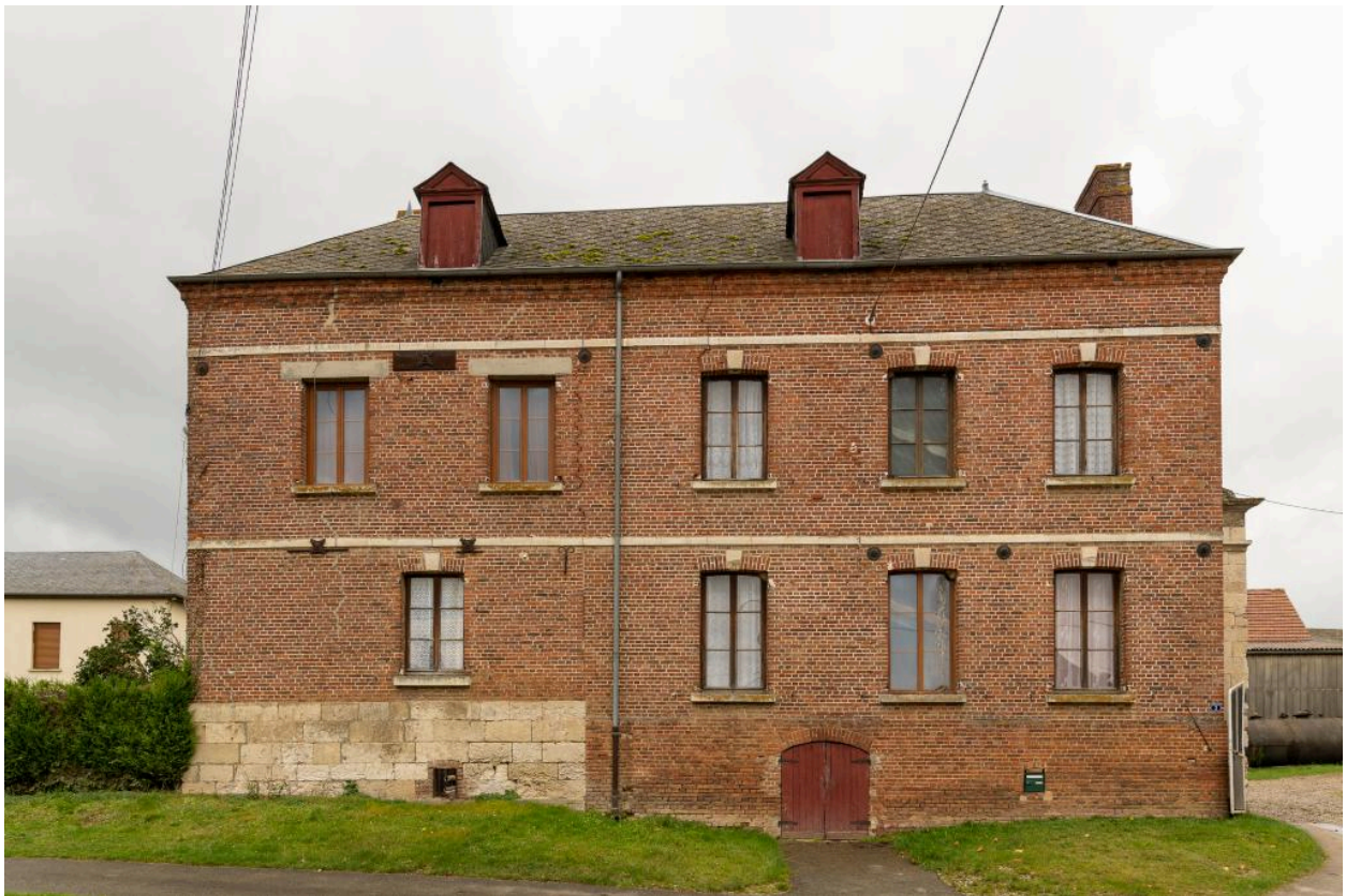
Vue depuis l'est de l'extension en brique du logis, premier tiers du 19e siècle.
