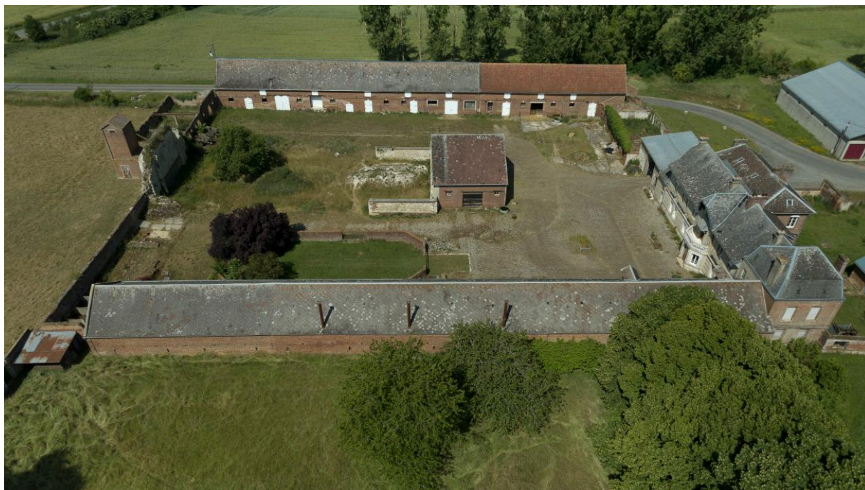
Vue aérienne depuis l'est.
