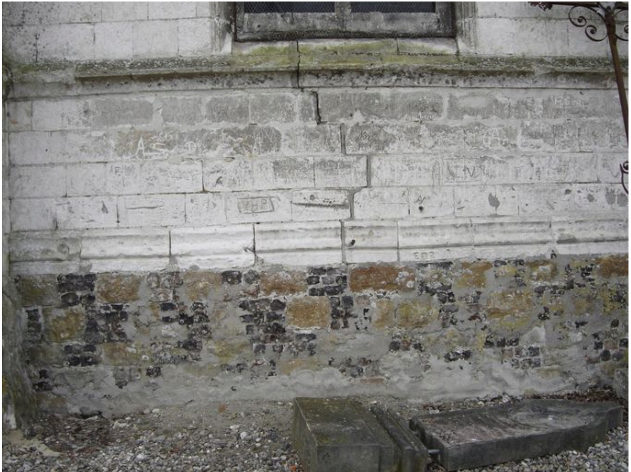
Vue sur le soubassement du choeur.
