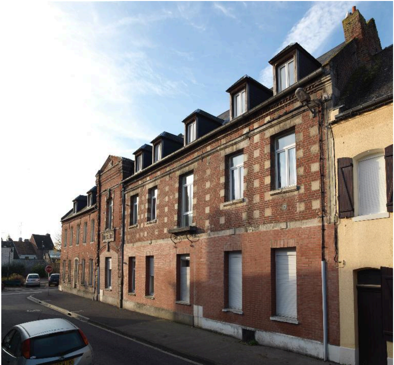
Vue générale depuis le nord.
