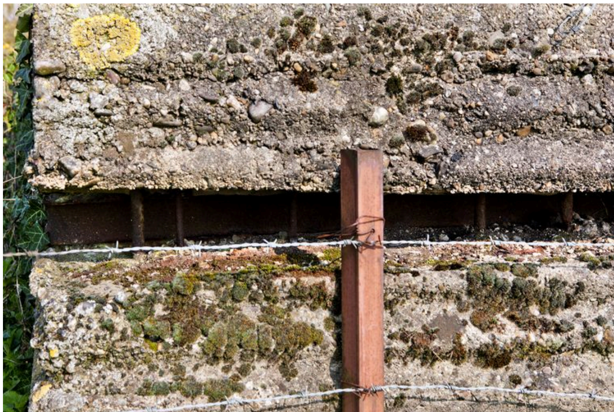
Elévation ouest, détail d'une cellule d'éclatement
