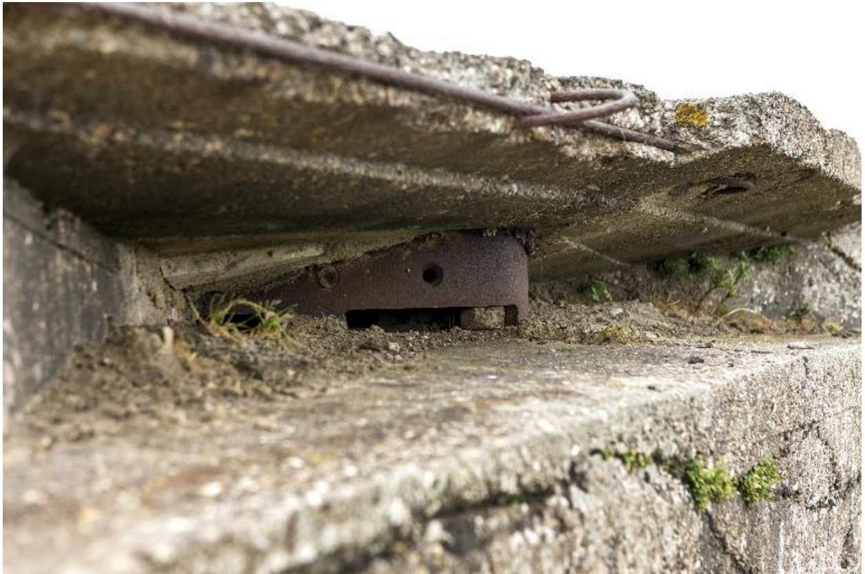
Elévation ouest : détail de l'observatoire cuirassé dans son embrasure
