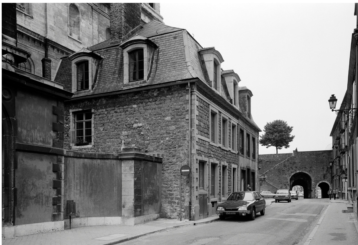
Vue d'angle sud-ouest.
