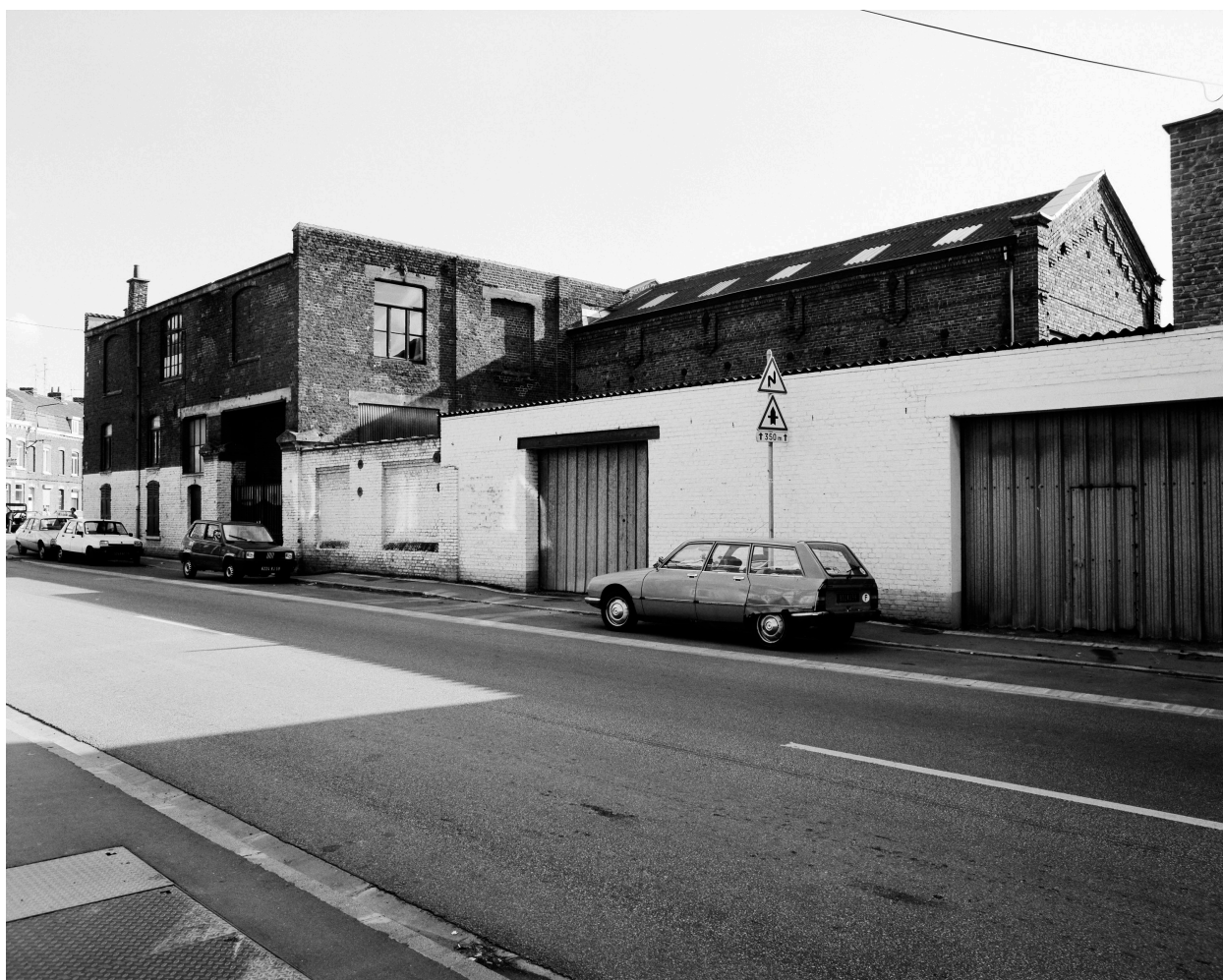
Atelier de fabrication, élévation rue Roger-Salengro.
